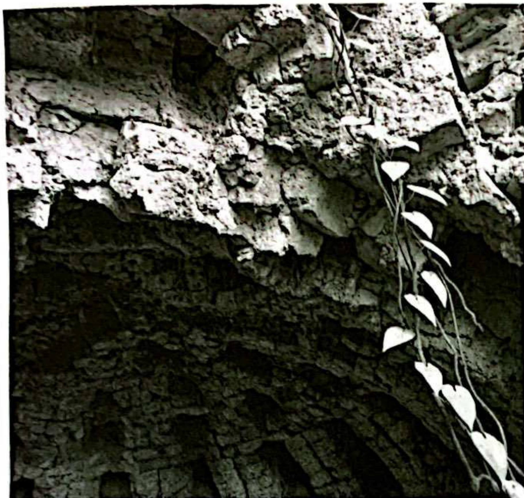
Figura 3. Messina, Particolare della volta traforata in fase di crollo della fornace per laterizi A009 (foto A. Chillemi, 2024).
