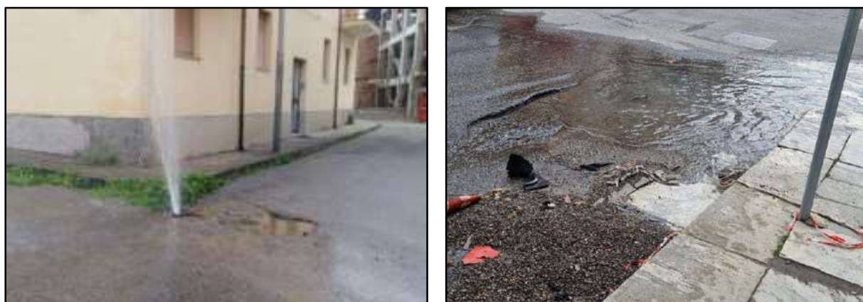
Fig.7. Perdite reali o fisiche in un acquedotto
