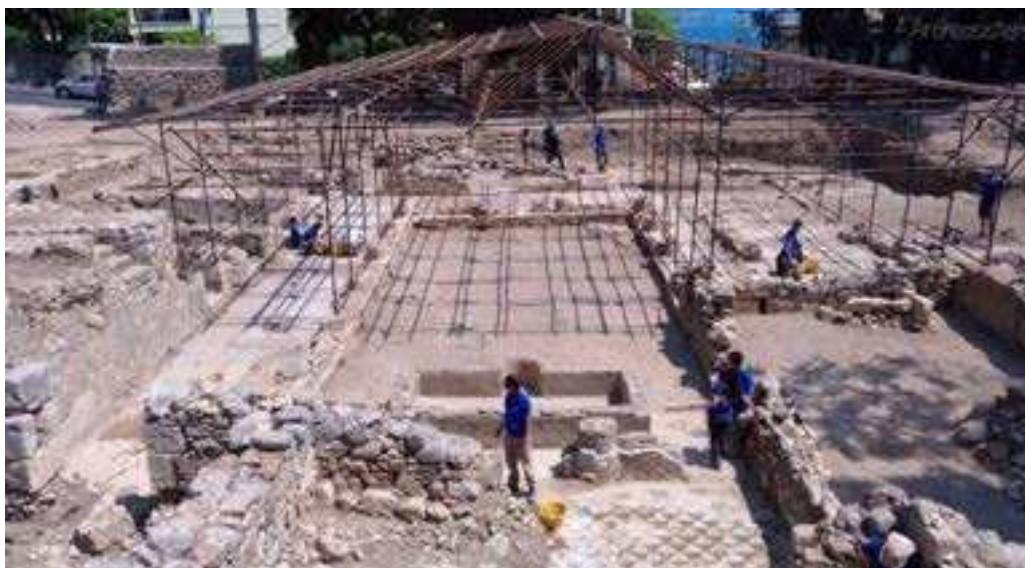
Fig. 52 Équipe del Di.C.A.M. impegnata nelle attività di scavo dei vani della Domus 1.
