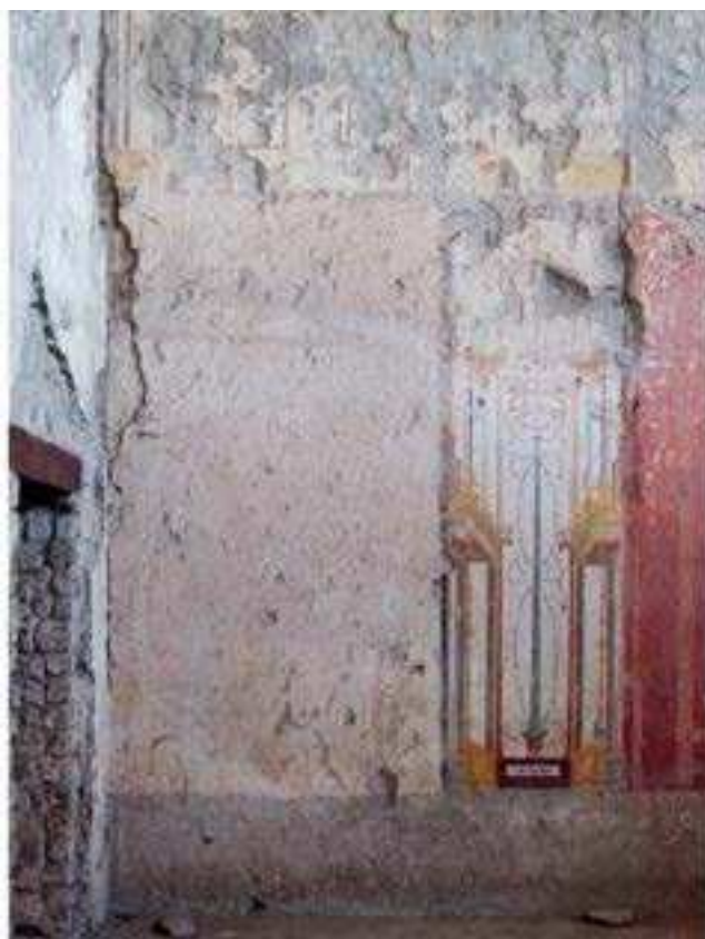
Fig. 4 Casa dei Pittori a lavoro, ambiente 12. Parete N, tratto orientale. Pannello sul quale stava avvenendo la stesura dell'arriccio (da ESPOSITO 2016)
