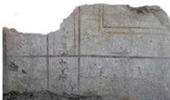
PARETE N-TRATTO OCCIDENTALE (USM 152)
