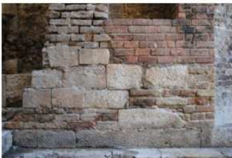
Fig. 63 Particolare di alcuni elementi della stoà ellenistica inglobati nelle murature in opus latericium della Naumachia (da VENUTI 2022)
