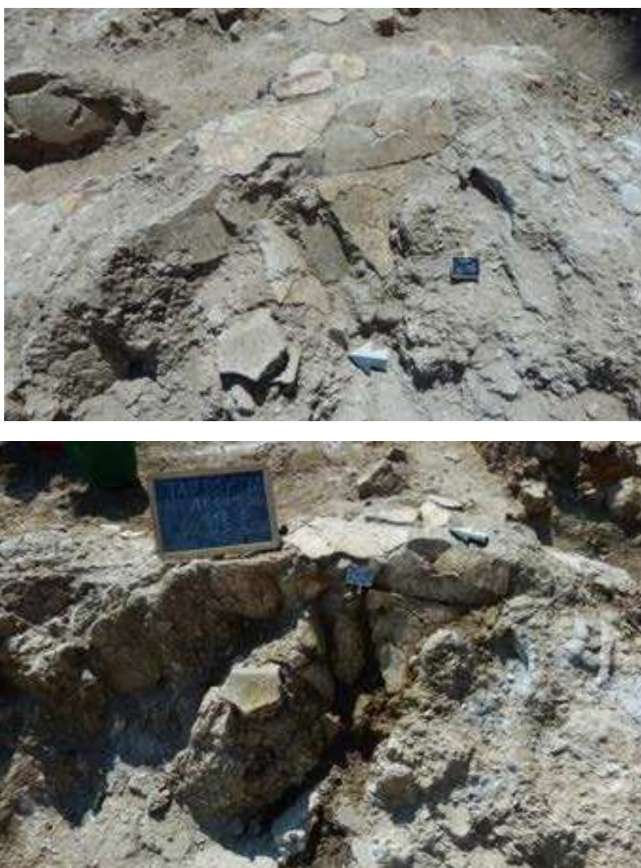
Fig. 122 Ambiente 21. Intonaci in crollo. In alto da US 3095, in basso da US 3258.
