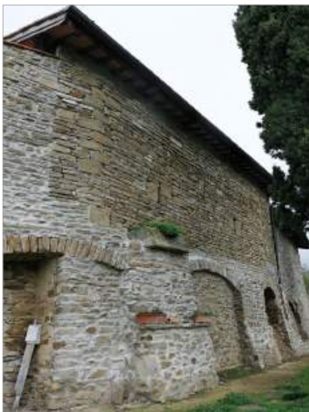
fig. 82 – Gavignano: il muro di cinta del castello è riutilizzato come perimetrale est del CA 2.
