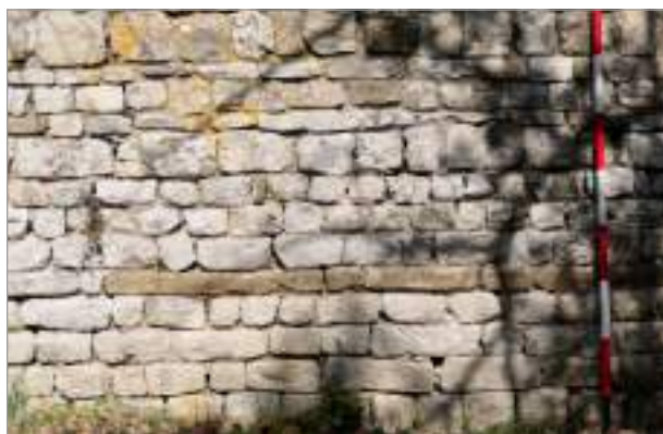
fig. 147 – Monastero di S. Maria a Casignano: particolare di una muratura di XV secolo (Tipo 3A).
