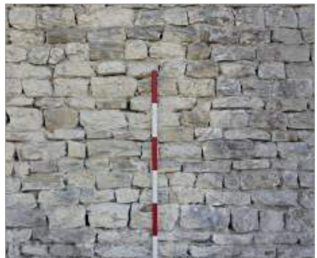
fig. 145 – Particolare della tecnica muraria impiegata nel monastero di S. Maria a Casignano (Tipo 3).
