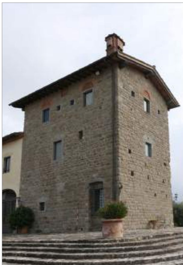
fig. 88 – Montemasso: la casatorre (CF 1).
