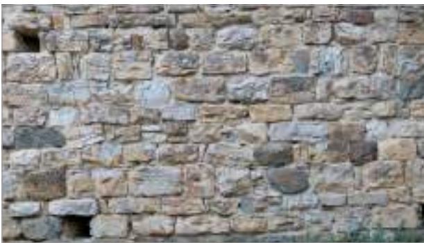
fig. 142 – Torre di Quarate: particolare del paramento murario (Tipo 2).
