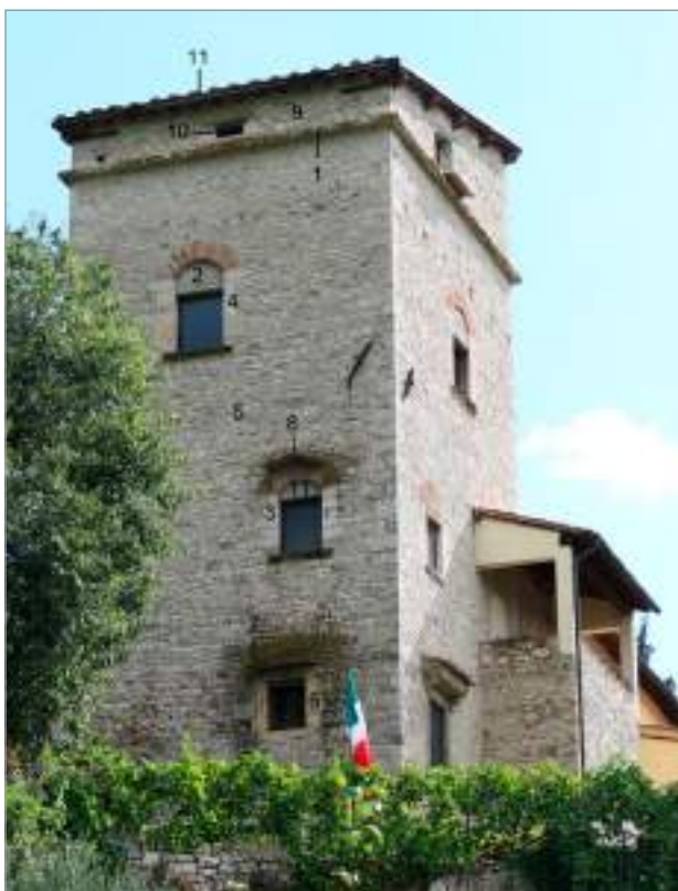
fig. 95 – Torre Terigi: individuazione delle principali unità stratigrafiche murarie nel lato ovest della torre.
