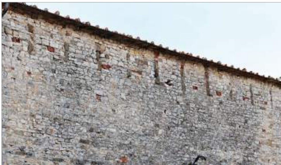
fig. 134 – Poggio a Luco: particolare dei beccatelli.
