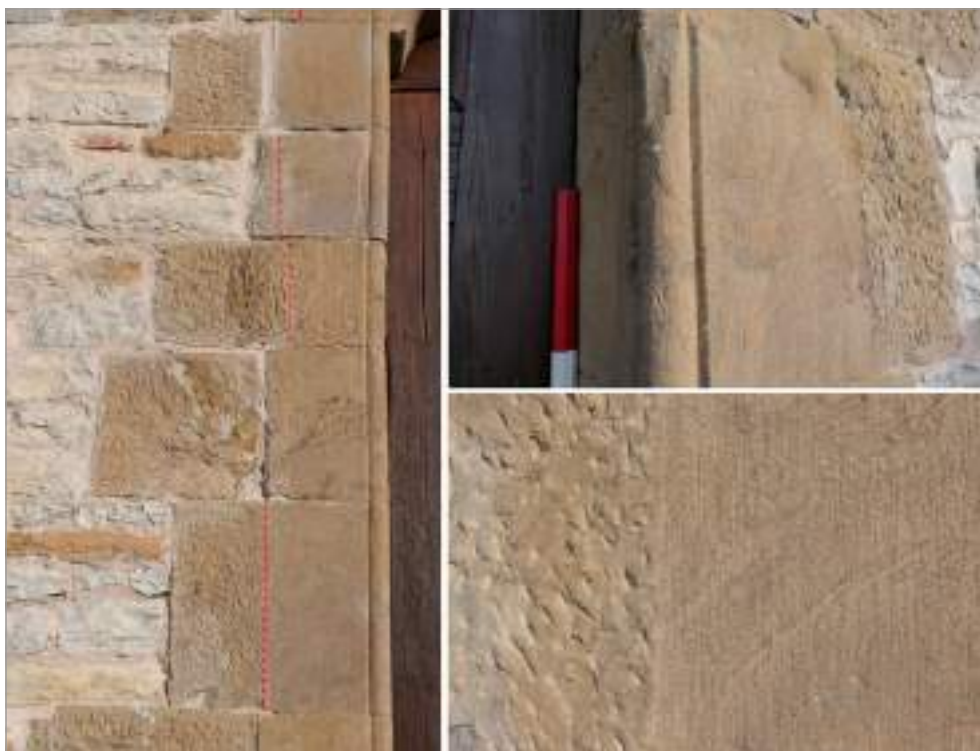
fig. 103 – Oratorio di S. Caterina, portale: a sinistra, lo stipite con indicate a tratteggio le parti non spianate dei conci, destinate ad essere ricoperte da intonaco; a destra, particolari delle tracce di lavorazione con uno strumento a punta (picconcello o subbia) e a gradinal/ciseau grain d'orge.
