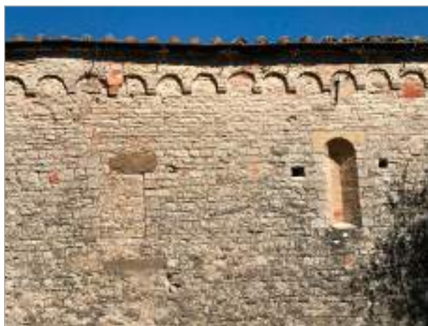
fig. 54 – Oratorio di S. Gherardo: particolare delle monofore e delle arcatelle pensili nel fianco sud.
