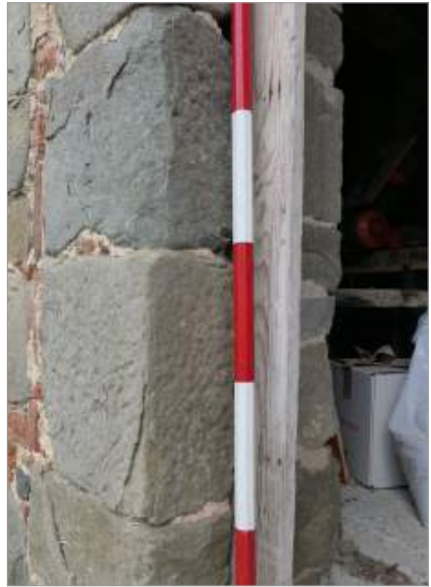
fig. 138 – Podere Gavignano: conci spianati a subbia reimpiegati negli stipiti della porta di un annesso agricolo del podere.
