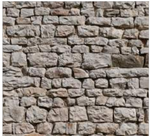
fig. 144 – Particolare della tecnica muraria impiegata nell'oratorio di S. Gherardo a Villamagna (Tipo 3).
