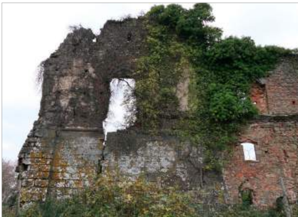
fig. 126 – Palazzaccio a Marcignano: la torre (CF 1) inglobata nelle strutture del palazzo.
