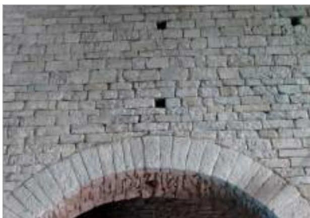
fig. 49 – Pieve di S. Donnino a Villamagna: particolare del paramento murario interno.
