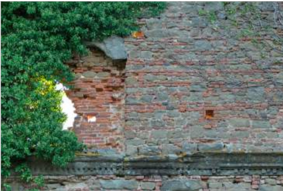
fig. 130 – Palazzaccio a Marcignano: la bifora e la sottostante cornice marcapiano.
