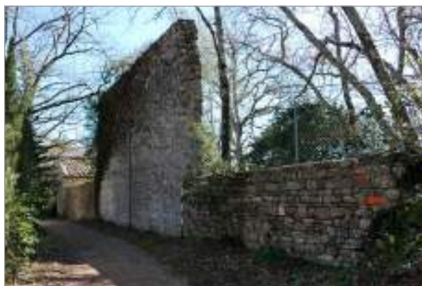
fig. 29 – Monastero di Casignano: il muro perimetrale nord.
