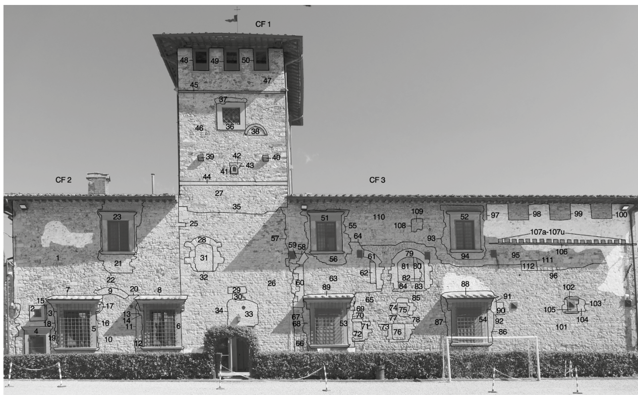
fig. 109 – Le Tavernucole: analisi stratigrafica del prospetto nord (in bianco i resti di intonaco ancora visibili).
