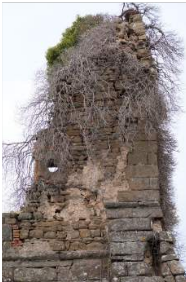
fig. 128 – Palazzaccio a Marcignano: la parte superiore della torre (CF 1) conserva la muratura in arenaria macigno della struttura originaria.
