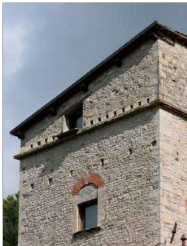
fig. 96 – Torre Terigi: la parte superiore della torre, sopraelevata per realizzarvi una colombaia.
