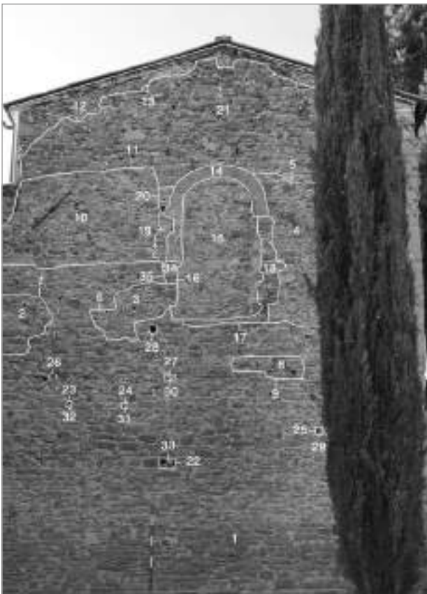
fig. 73 – Montisoni: analisi stratigrafica del prospetto est della chiesa di S. Lorenzo.
