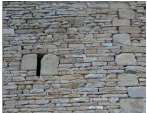
fig. 141 – Gavignano: particolare del diverso grado di finitura tra paramento (Tipo 5) e elementi architettonici.
