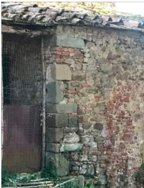
fig. 75 – Fonte S. Martino: particolare dell'angolata in conci quadrati di recupero in un casolare vicino al sito di Ripacozza, di cui forse ha reimpiegato le pietre.
