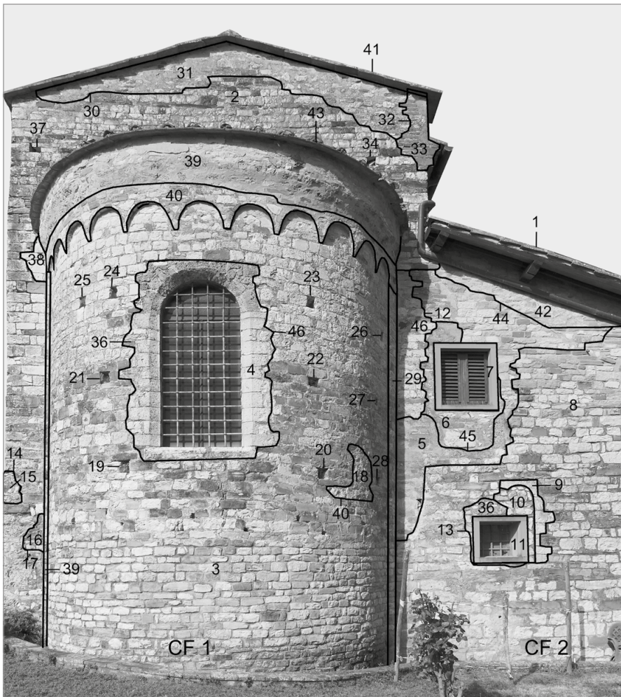
fig. 51 – Pieve di S. Donnino a Villamagna: analisi stratigrafica del prospetto orientale (CF 1 e CF 2).
