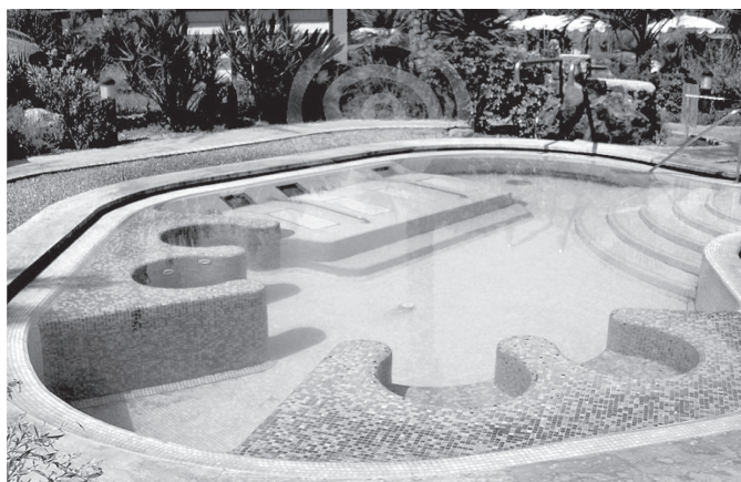
Fig. 3. Le piscine geotermiche delle Terme Marotta (Fonte: www.oasidellasalute.it).
