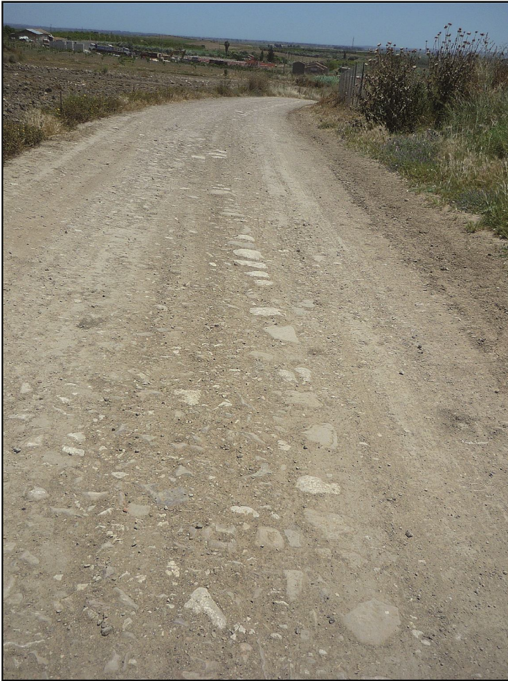
Fig. 1: Tracce di basolato presso il Castellito di Ramacca (foto di M. Sfacteria)
