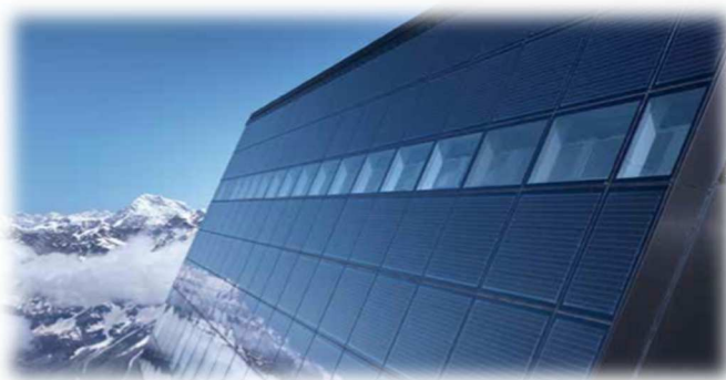
Figura – Esempio di una facciata che produce energia
