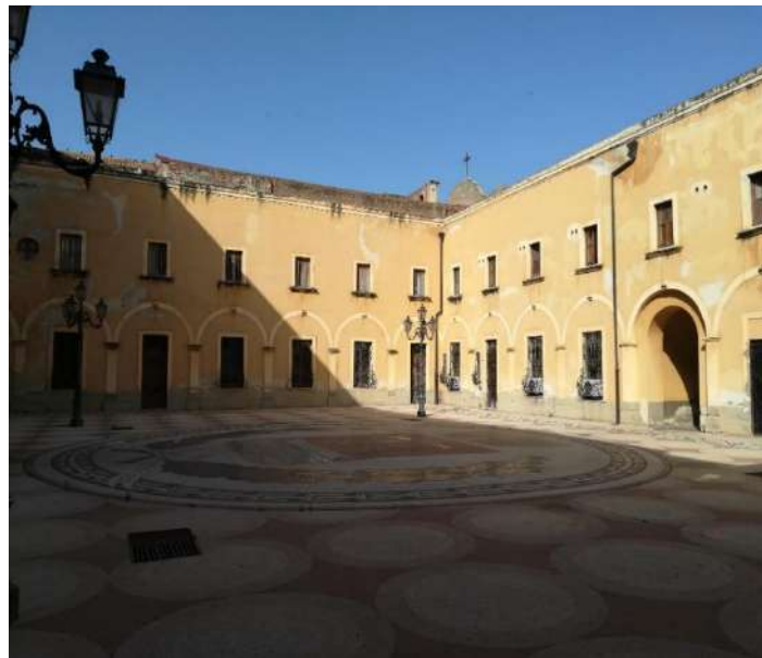
Fig. 23. Chiostro dell’antico convento del Carmine di Milazzo
