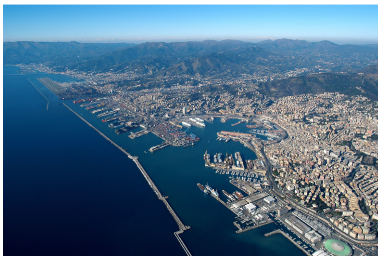
Figura 2.49: Porto di Genova con diga foranea di protezione.
