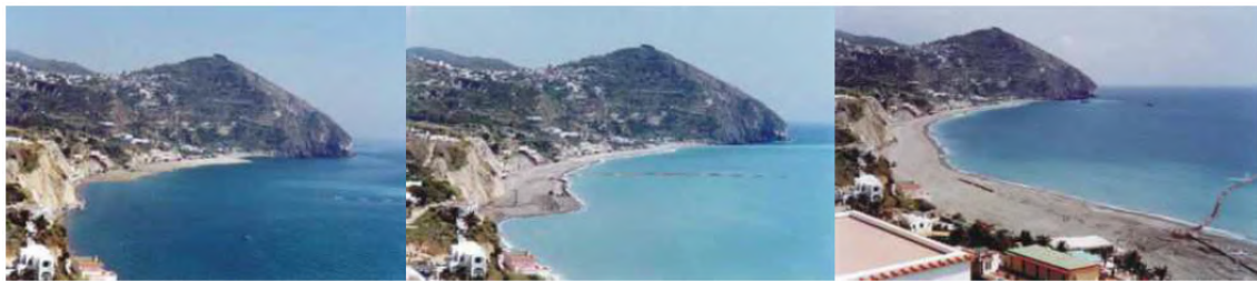
Figura 2.43: Realizzazione del ripascimento della spiaggia dei Maronti (Ischia) (fonte: Atlante APAT).
