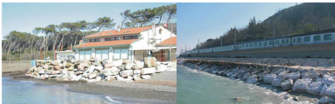
Figura 2.39: Scogliera radente a ridosso di una struttura esistente (a sinistra) o di un'infrastruttura ferroviaria (a destra) (fonte: Atlante APAT).
