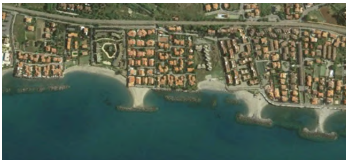
Figura 5.19: Dettaglio di Sanginetto Lido: la linea di costa è individuata dalle scogliere radenti che proteggono le abitazioni, la spiaggia non esiste più (Fonte: Google Earth).
