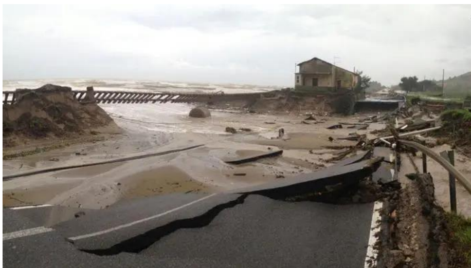
Figura 2.1: Danni causati da un evento contemporaneo di alluvione e mareggiata a Bruzzano (RC) tra il 31 ottobre e il 2 novembre 2015.
