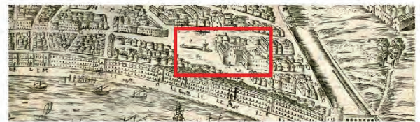
Figura 3c: Messina Città Di Maria Vergine (rit.), V. M. Coronelli 1691, Collez. Priv., La Chiesa di S. Giovanni con il Gran Priorato di Malta (ds.) e la fontana monumentale (sin.) in piazza.
