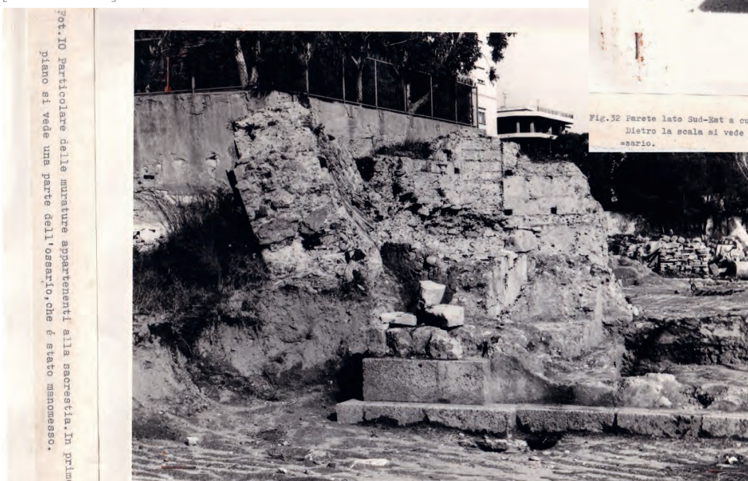
Fig. 3.47 (sotto) Foto di scavo dal cantonale est della Chiesa verso l'abside [Archivio MuMe]
